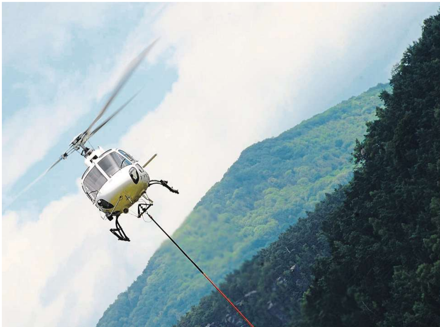
Na laně Vrtulník osazuje nad Horním Žlebem ocelové nosníky pro plot, který bude chránit trať a roubenku, na niž loni málem spadl mnohatunový balvan. Celá ochrana vyjde na 9 milionů korun, částečně jí platí Děčín z rozpočtu, část je z evropské dotace. Foto: Ondřej Bičíš, MAFRA
